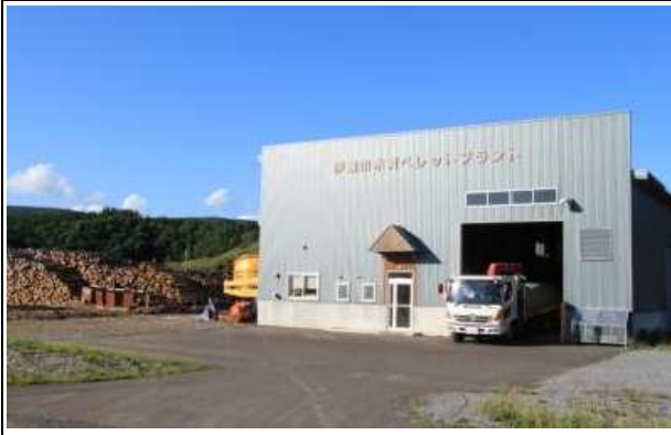
木質ペレット製造プラント
