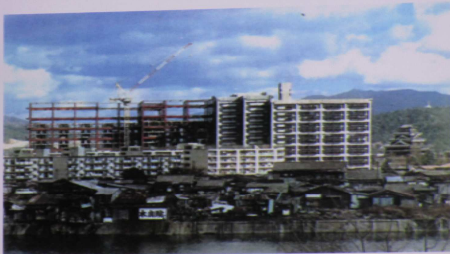
基町高層住宅建設中(昭和45年11月)
